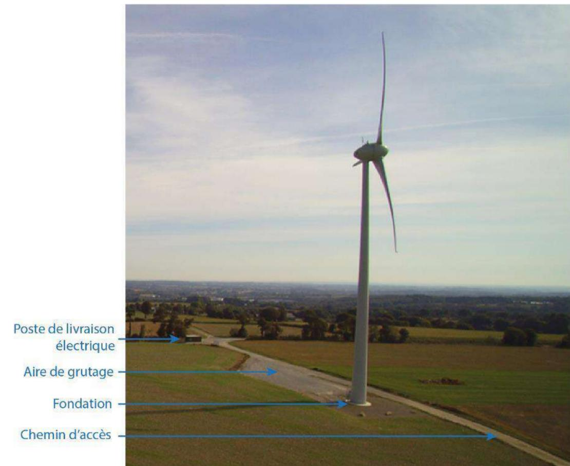
Figure 2 : Une éolienne et ses aménagements annexes (Source : AEPE Gingko)
